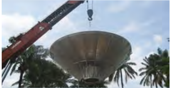
Montage de l'antenne
