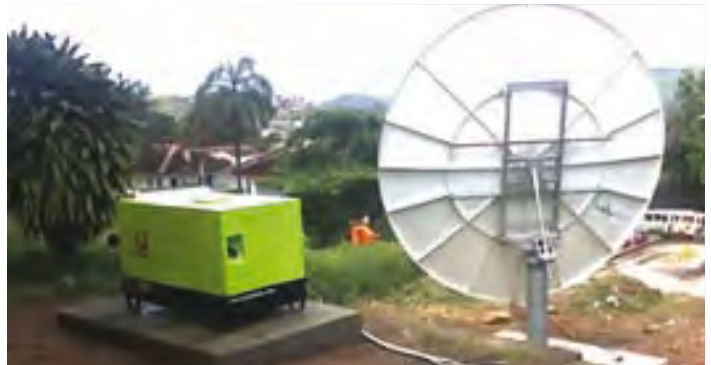
Raccordement à l'électricité
