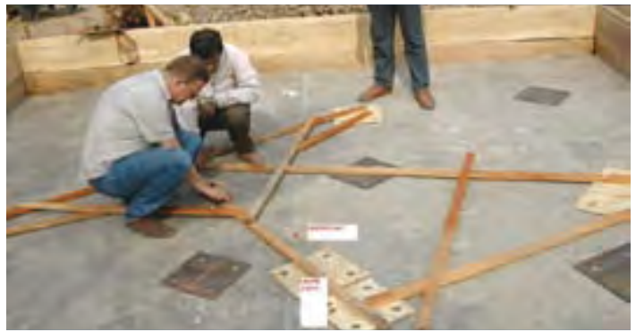
Préparation de la dalle
